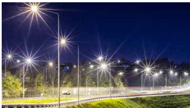
Éclairage de rue
